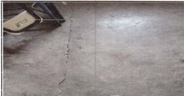
Foto 4: Sustitucion de piso de cemento liquido por (ceramico).
