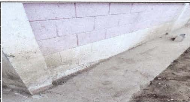
Foto 7: Pintura en muros exteriores e inferiores.
