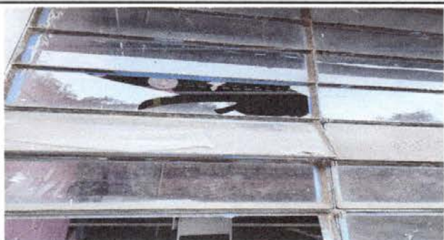
Foto 3: Sustitucion de vidrios.
